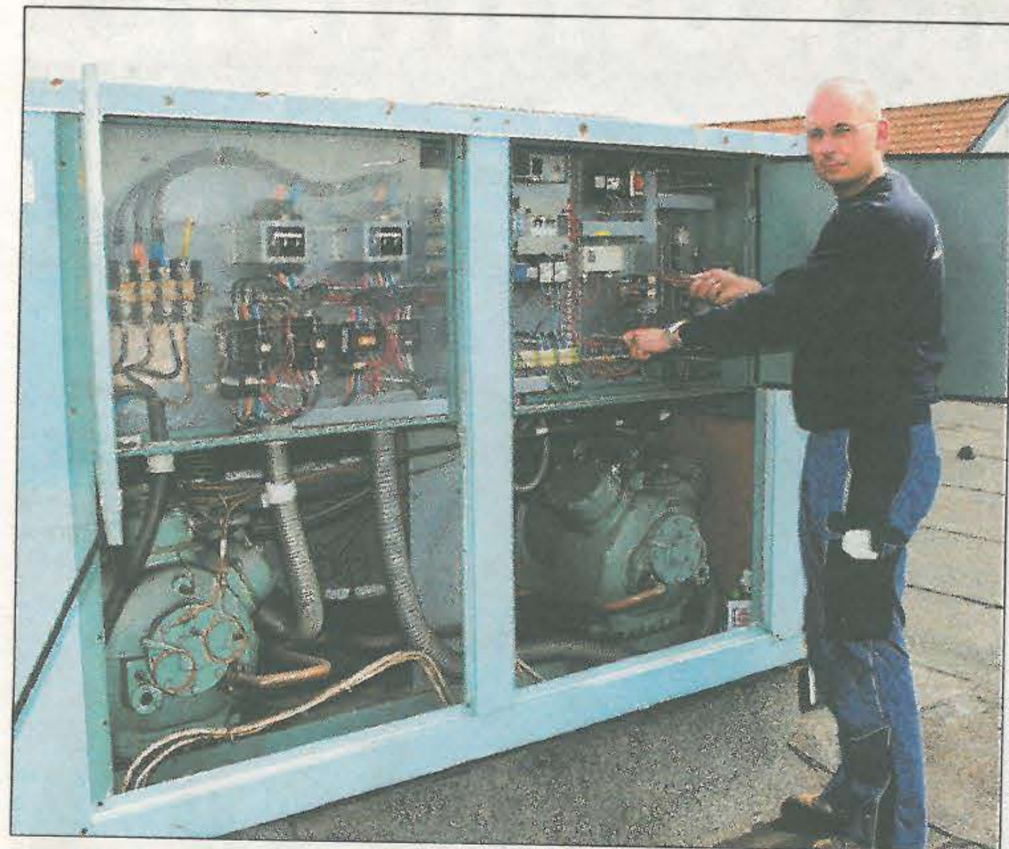
Thorben Koll bei der Einstellung des Verflüssigungsdrucks an einer Klima-Anlage auf dem Dach eines Geschäftshauses.
