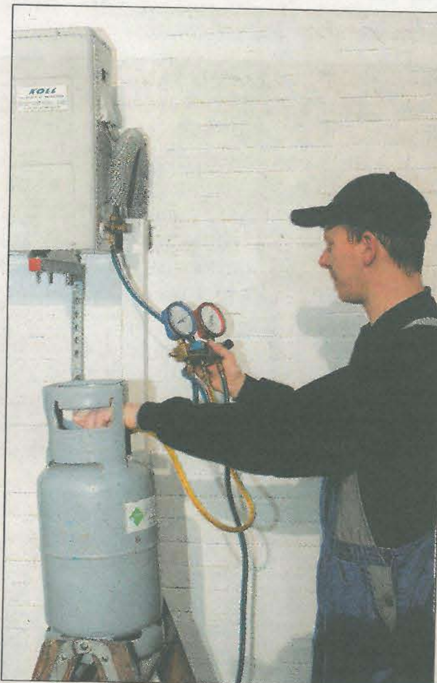
Sebastian Eisenschmidt bei der Überprüfung einer Klima-Anlage an einem Wohnhaus.
